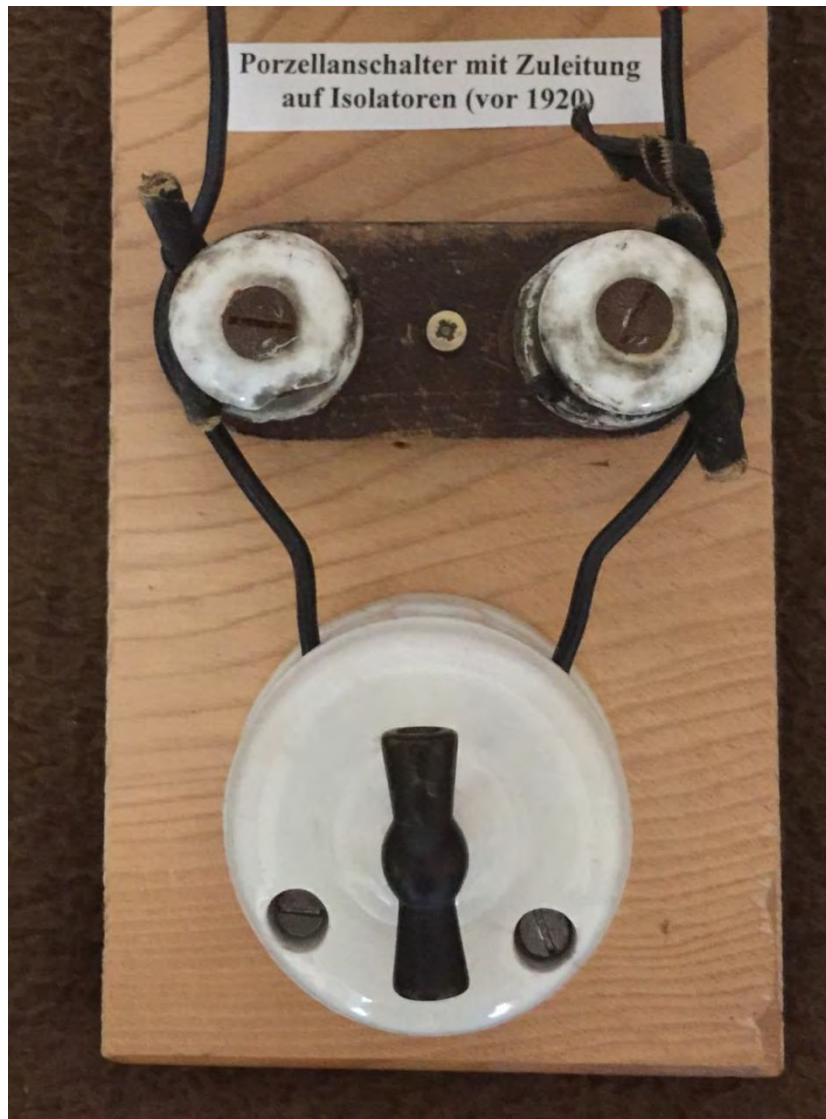
Bild 27: Schautafel mit Porzellschalter und Zuleitung auf Isolatoren (12/2023)
