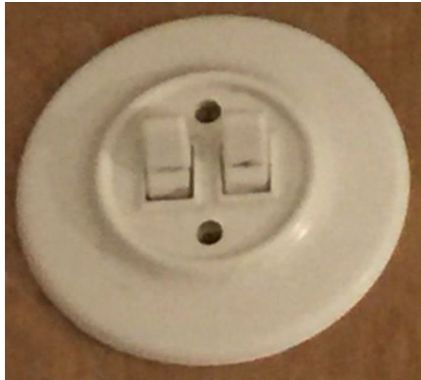
Bild 45: Serienschalter (Kippschalter) von 1956/1957
