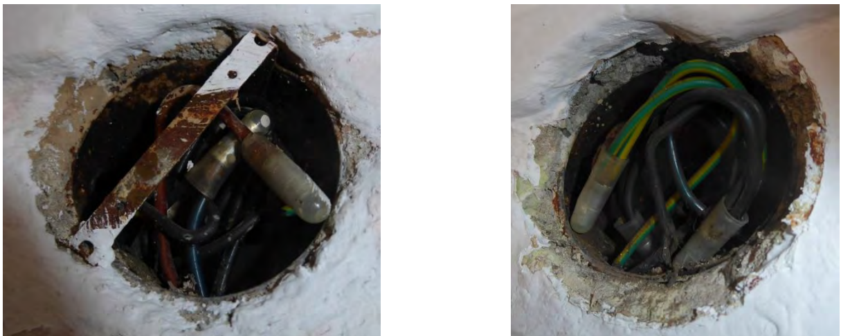
Bild 9: alte Verteilerdosen mit Presshülsen-Verbindungen 17
