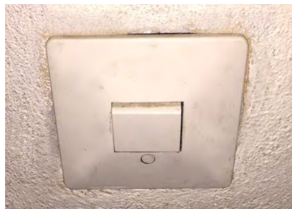
Bild 39: breitere Wippenschalter (links Deckel noch mit Schrauben), ca. 1970? In den 1970 oder 1980 Jahren wurden auch die einfachen Schalter und Steckdosen viereckig. In der DDR machte man dann sogar die Schalterdosen quadratisch.
