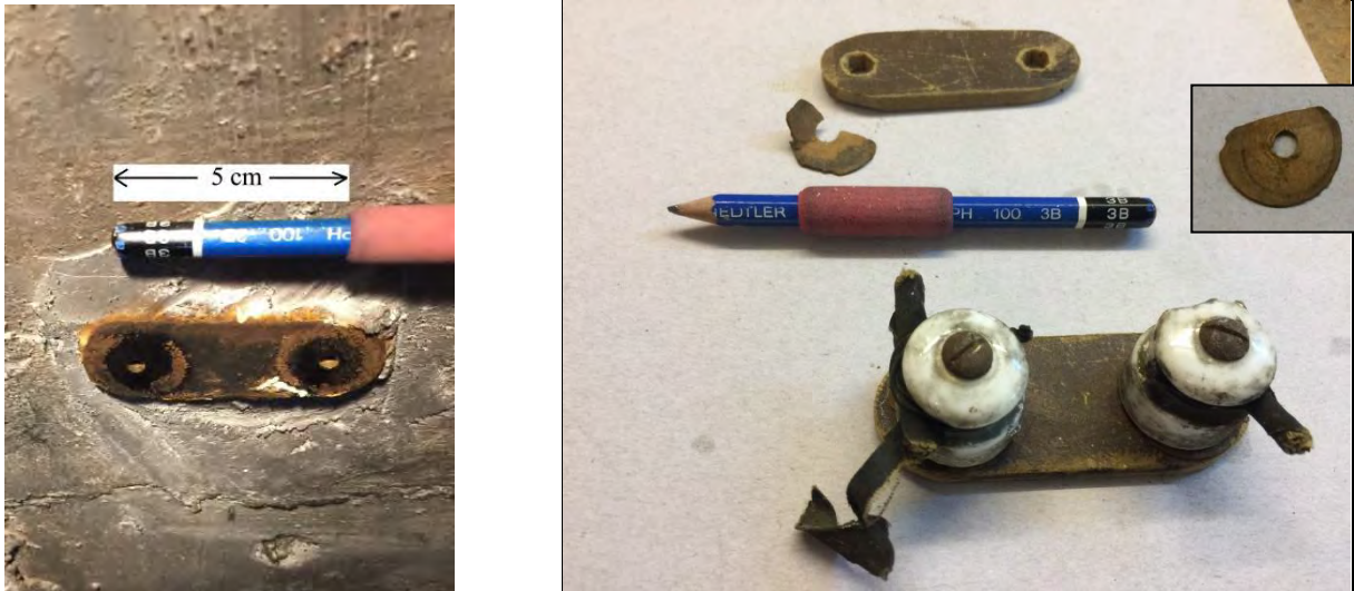
Bild 25: links Holzsockel in der Kellerdecke, rechts "Isolierrollen" mit nachgebautem Holzsockel (12/2023)
