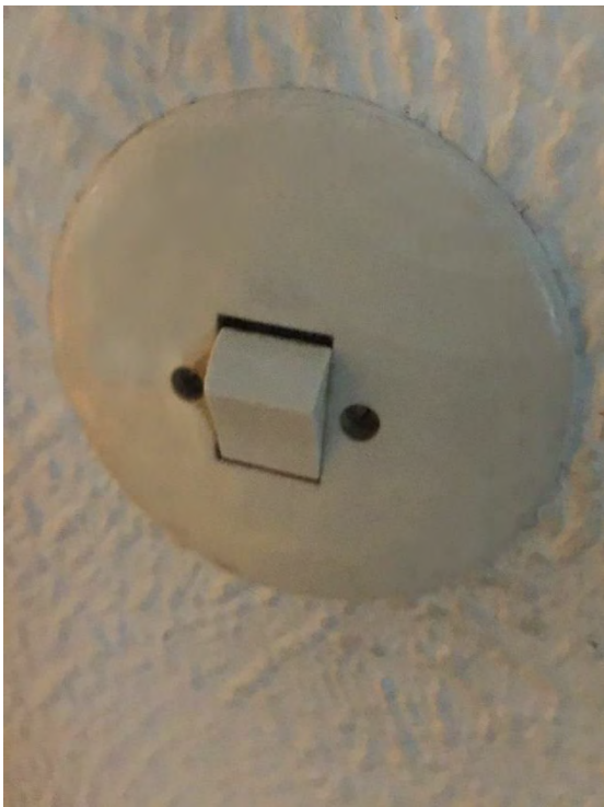
Bild 39: breitere Wippenschalter (links Deckel noch mit Schrauben), ca. 1970? In den 1970 oder 1980 Jahren wurden auch die einfachen Schalter und Steckdosen viereckig. In der DDR machte man dann sogar die Schalterdosen quadratisch.
