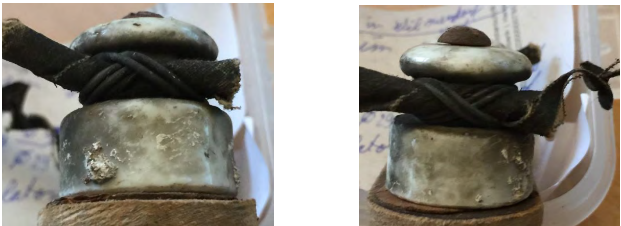
Bild 26: Befestigung des Leiters mittel dünnem Draht und "Kreuzbund" (12/2023)
