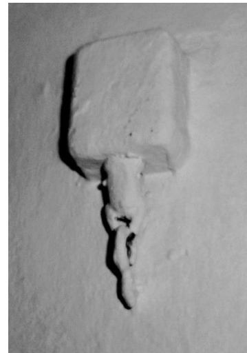
Bild 12: Klingelknopf (links) und Zugschalter über Badewanne für Dienstbotenklingel
