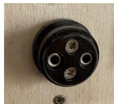
Bild 22: links Klingelknopf (Unterputz) mit Anschlusskontakt für mobilen Klingelknopf, rechts Anschlussbuchse (Aufputz) für mobilen Klingelknopf von 1937
