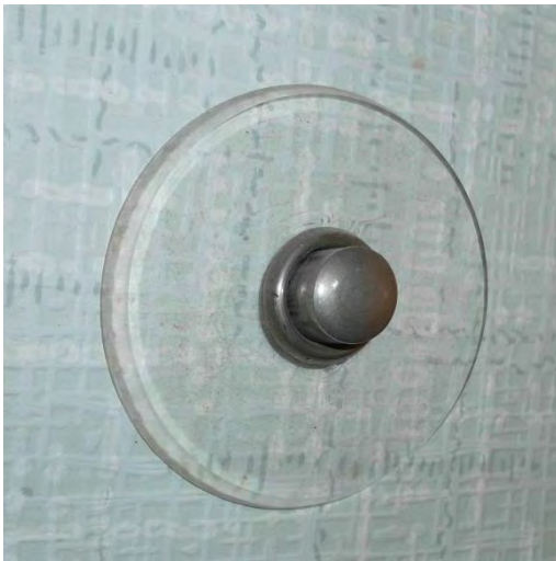
Bild 12: Klingelknopf (links) und Zugschalter über Badewanne für Dienstbotenklingel
